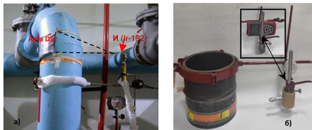
а – радиографическое исследование сварного соединения трубопровода к главному циркуляционному насосу первого контура реактора ВВР-К (И – источник излучения Ir-192 закреплен в разработанном устройстве позиционирования (б) при радиографическом контроле прямолинейных участков и отводов диаметром до 380 мм.
